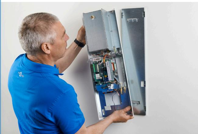
**19** Cableado del sistema PROTECT 800i C™/1500i C™. Un cable al sistema de alarma y el otro cable a la alimentación de 115 / 130 / 230 V.
