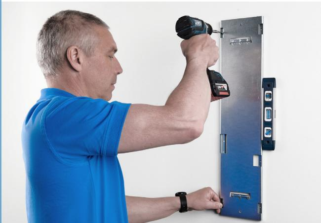
**17** Al montar en esquinas, primero se deben atornillar los soportes de esquina (incluidos) en la placa de montaje posterior de la máquina.
