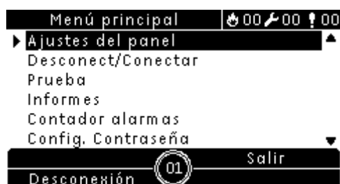
Figura 16: Menú principal del nivel de mantenimiento
