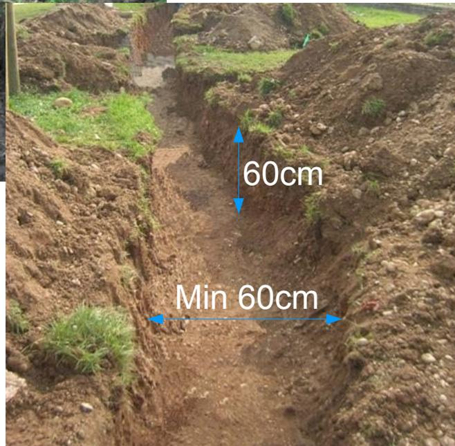
Efectuar la excavación con una excavadora siguiendo el recorrido establecido en fase de proyecto.
