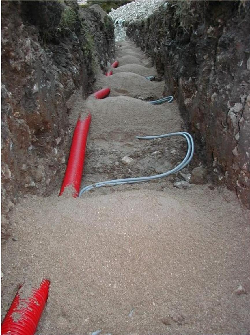
Cada sensor se tiene que cubrir con aprox. 20-25 litros de arena, suficientes para envolver completamente el sensor.
