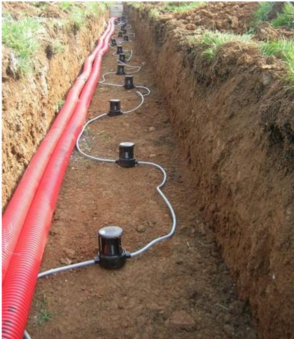
Una vez instalados los sensores, entubar los cables que conectan las líneas-sensores a las unidades de análisis.
