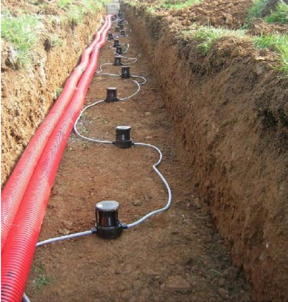
Es un sistema anti-intrusión de tipo enterrado para el control perimetral.
