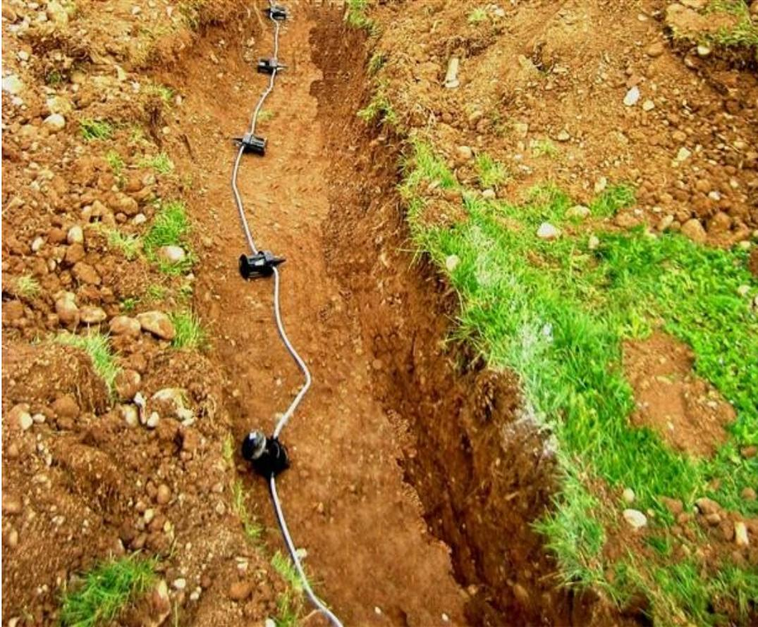
Extender la línea de los sensores a lo largo de la excavación.
