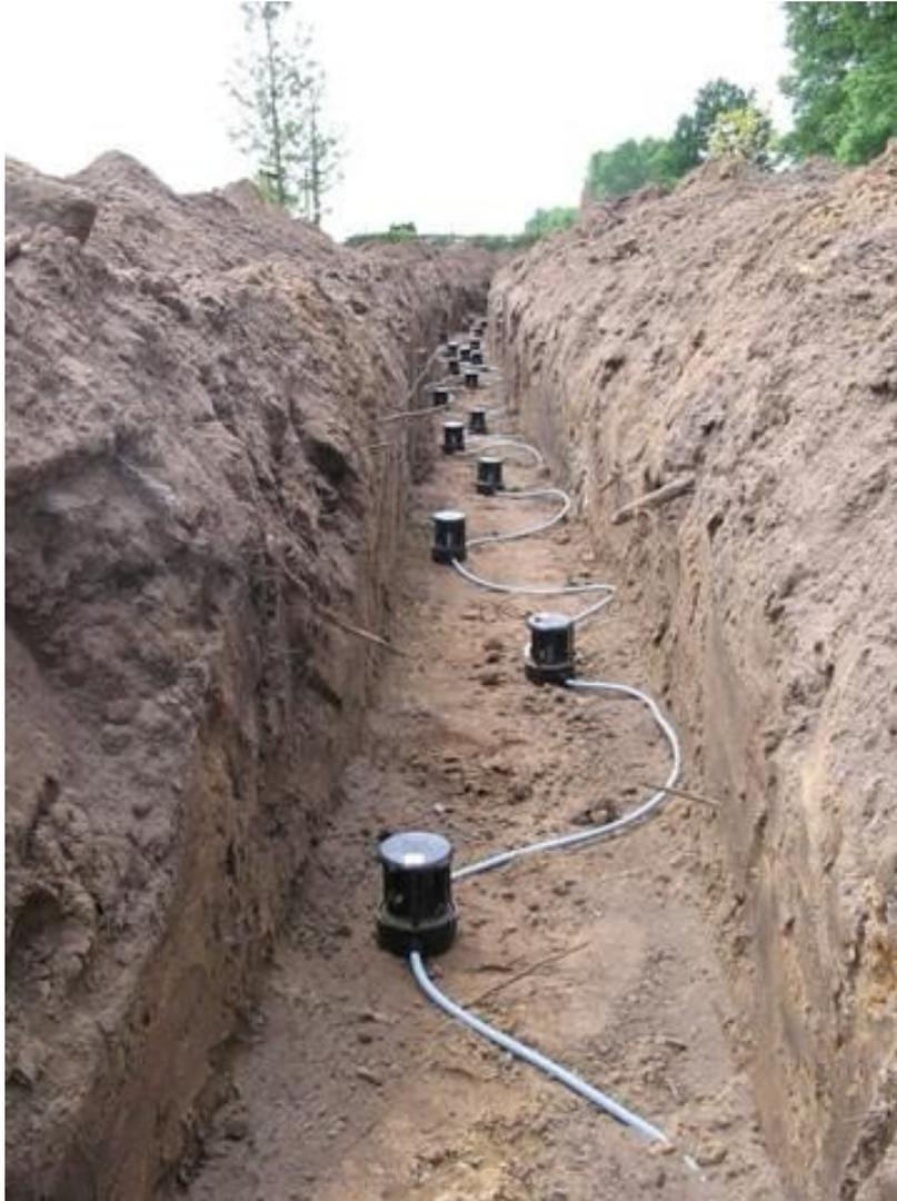
Cada sensor además tendrá que ser instalado fuera del eje (aprox. 20cm) respecto al sucesivo.
