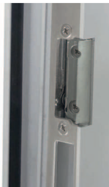
Modelo 99 con detalle del corte del perfil en la instalación
